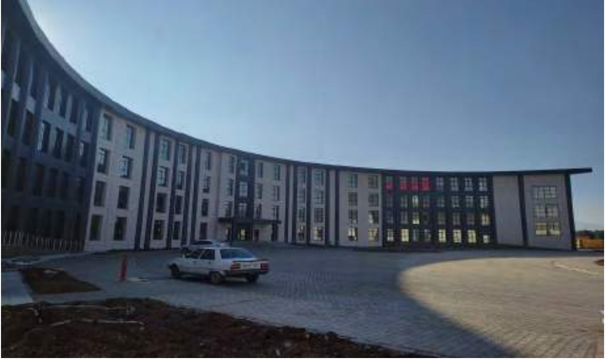
Resim.9.2.5. Tamamlanan ve kullanıma açılan morfoloji binası ve amfilerden görünüm
