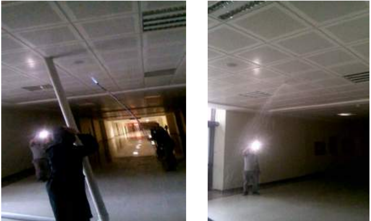
Resim 7.1.29. Yangın dedektörleri ve yağmurlama sistemi montajı
