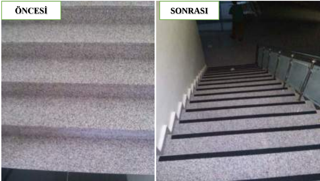
Resim 7.1.22. Merdivenlerde kaydırmaz bantlar
